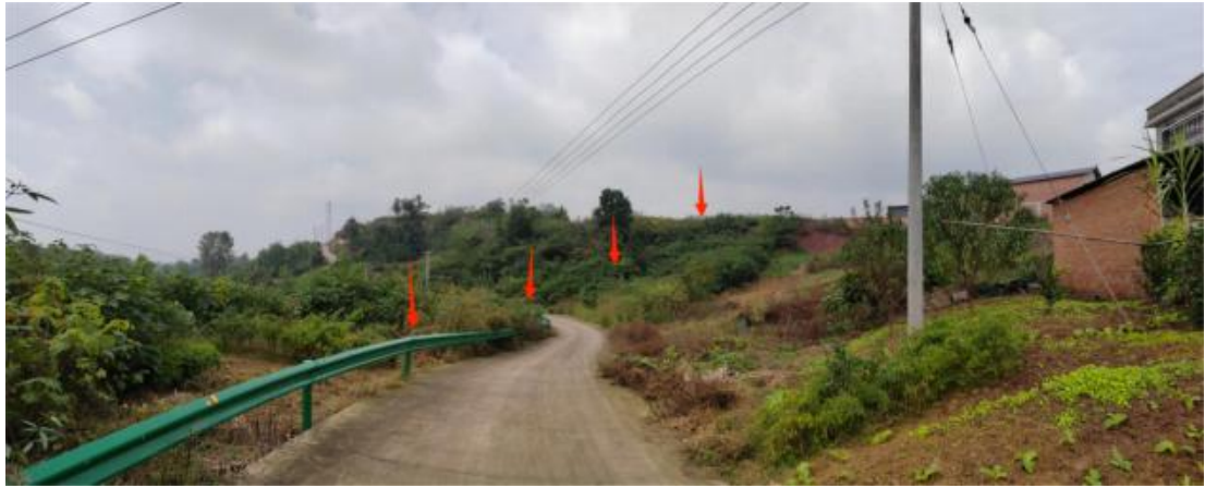
图 3.3-3 响石镇工厂后山断层地貌（镜向 NE）
