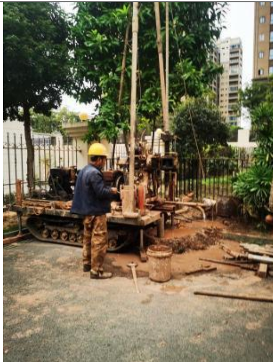
机台施工照片
